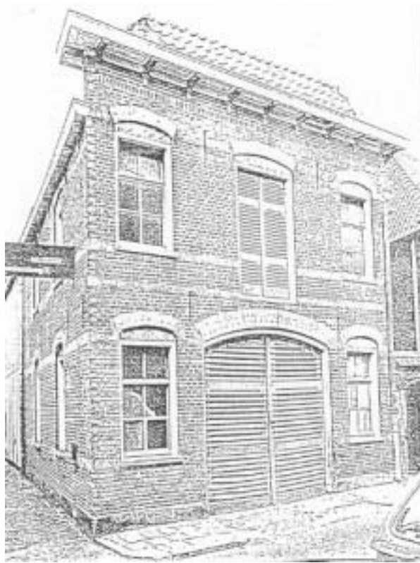
Houtdroogschuur van de Nederlandsche Stoomhoutdraaijerij en Meubelfabriek
